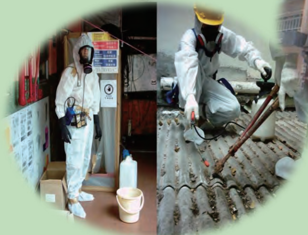
石棉檢查及清拆
