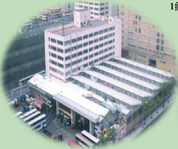
更換屋宇天面坑片及防水
